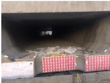
图9 预制梁体封锚电热毯覆盖养护
