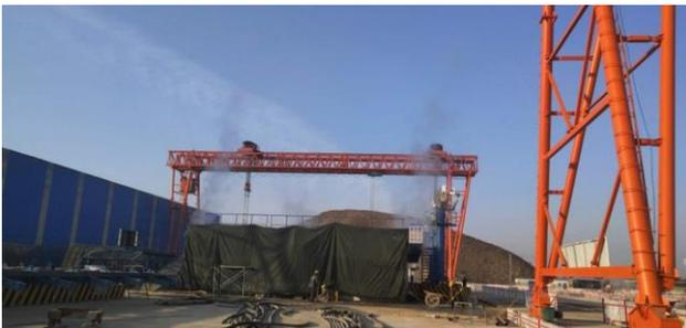
图 5 制梁区端头覆盖养护
