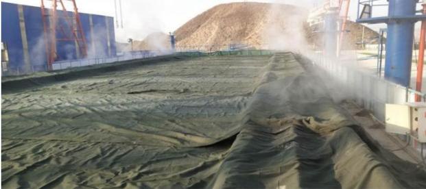
图 4 制梁区顶板养护
