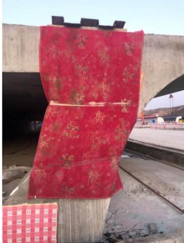
图8 预制梁体封锚电热毯覆盖养护
