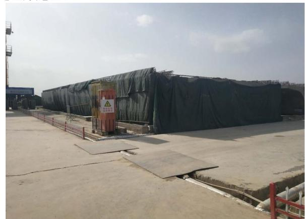
图 7 存梁区梁体压浆侧面和端头覆盖养护
