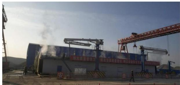
图 6 制梁区腹板保温板养护
