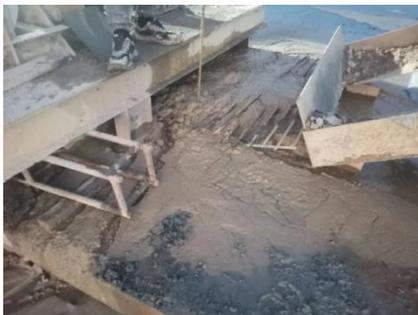
图 3 第 22 幅混凝土浇筑后期槽段内涌出大量膨润土絮凝物质
