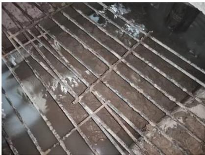
图 2 第 20 幅混凝土浇筑后期出现大量膨润土絮凝物质
