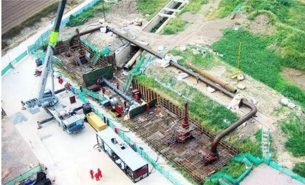
图4 输气管道不停输改造施工现场
