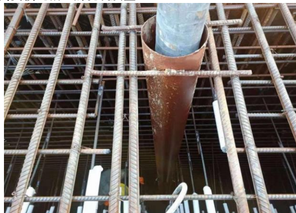
图3 高支模混凝土浇筑
