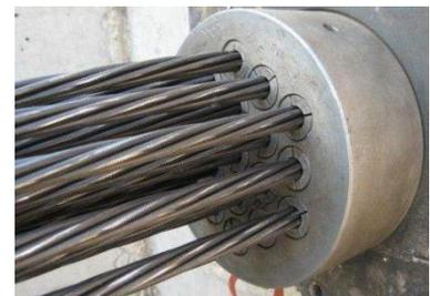
图 2 案例预应力锚索支护例图
