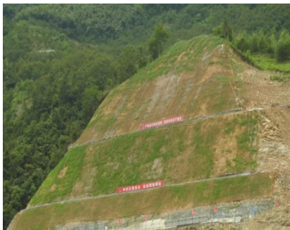
图 3 开挖完成后及时喷植混凝土防护 图 4 采用 BIM 技术设计的左岸 S 形上山便道 图 5 左岸成型的 S 形道路及支线
