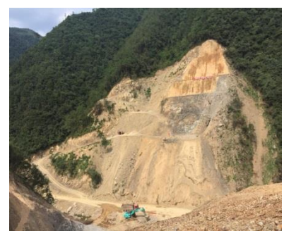
图 3 开挖完成后及时喷植混凝土防护 图 4 采用 BIM 技术设计的左岸 S 形上山便道 图 5 左岸成型的 S 形道路及支线
