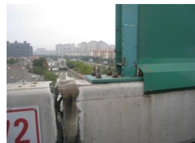
图1 梁体收缩对伸缩缝位置的声屏障H型钢立柱卡槽深度要求加大
