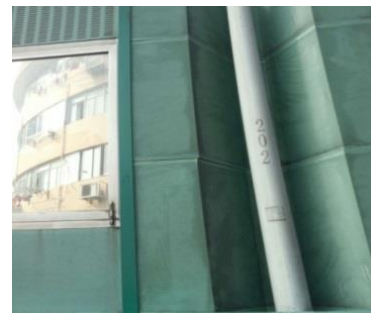
图2 路灯设置在声屏障内侧
