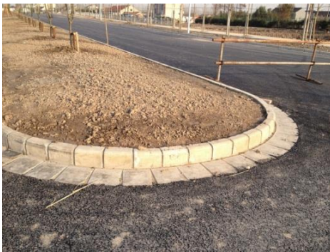
图8 圆弧顶侧平石常规布设
