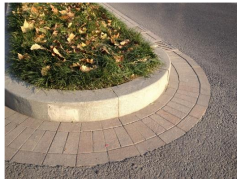
图9 圆弧顶侧平石单独设计精心施工
