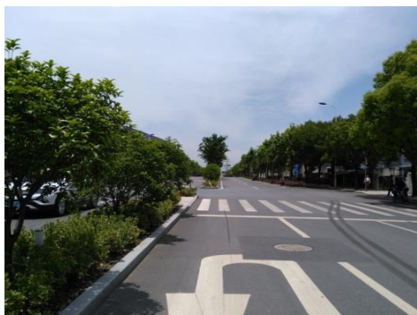
图 14 中分带绿化影响掉头车辆视线
