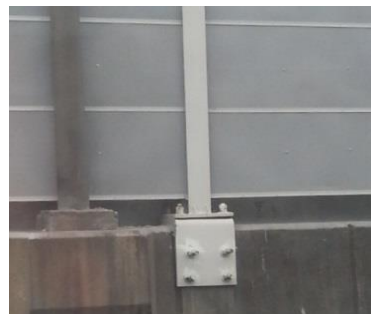
图3 骑马铁上安装H型钢立柱
