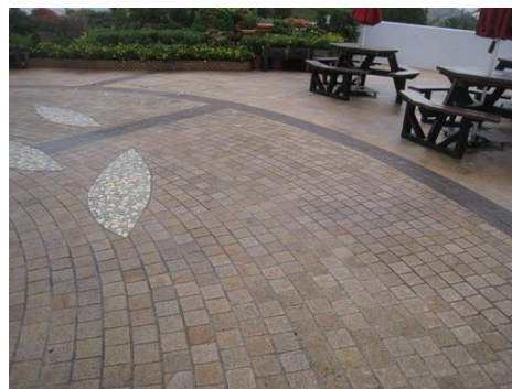
图5 采用顺圆弧方向铺设道板砖或料石
