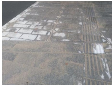
图11 不锈钢井框取代电力工井盖板
