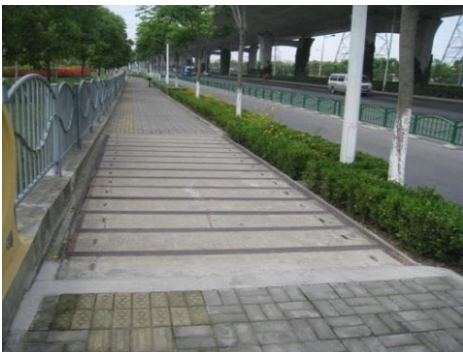
图10 桥头电力工井盖板对盲道的阻断
