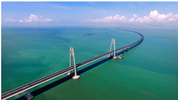
图 1 港珠澳大桥海上桥梁施工
