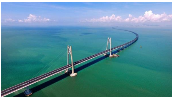
图 1 港珠澳大桥海上桥梁施工
