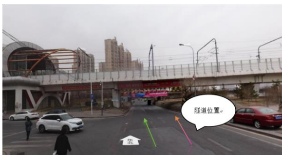
图 1 隧道开挖实际现场图
