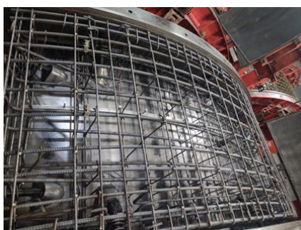
图8 钢筋笼安装入模图
