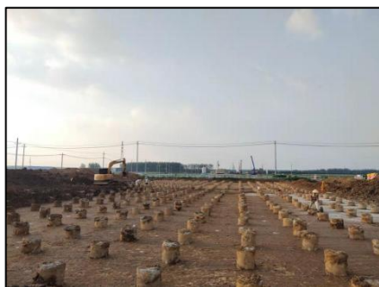
图7 全螺旋桩身施工验证施工效果
