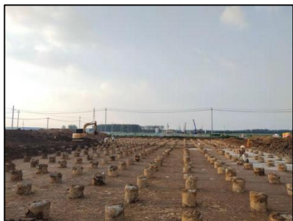
图7 全螺紋桩身施工验证施工效果
