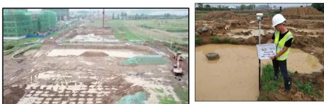
图 2 地下水埋深浅及工程现场雨季积水情况
