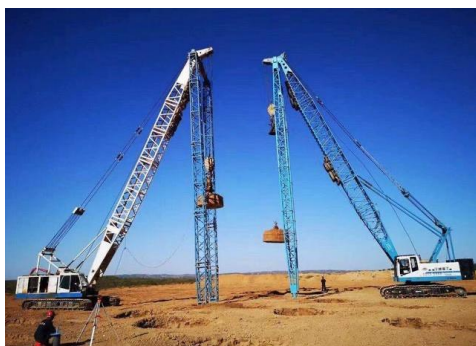
图1 为强夯法施工技术应用现场
