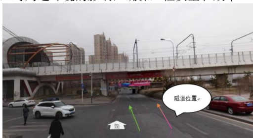
图1 隧道开挖实际现场图
