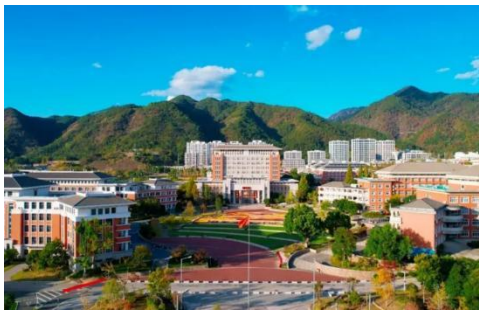
图 5 图书综合楼及教学区实景
