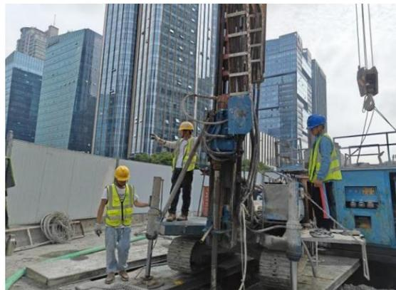
图 9 钻机引孔
