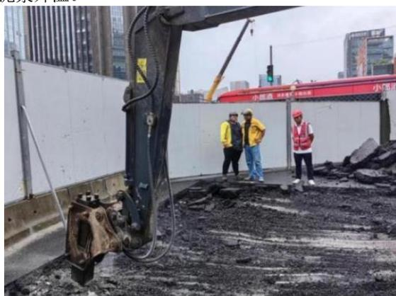
图 6 加固区沟槽开挖
