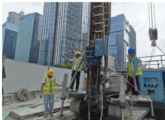
图 9 钻机引孔
