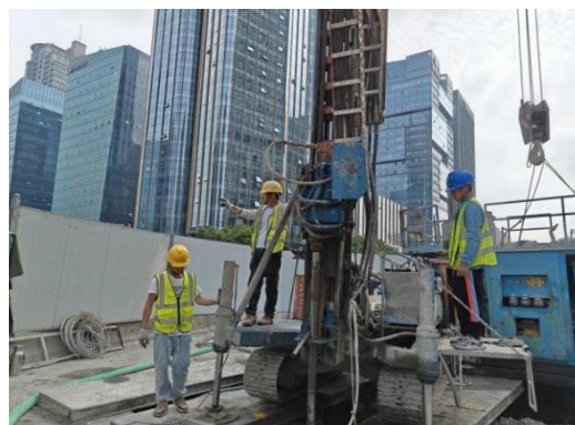
图9 钻机引孔
