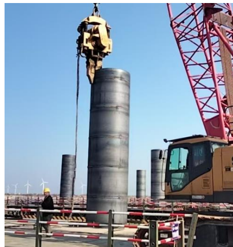
图1 钢护筒震动下沉图
