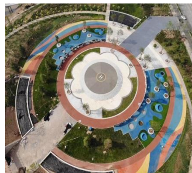
图3 飞行梦工厂(施工中实景照片)
