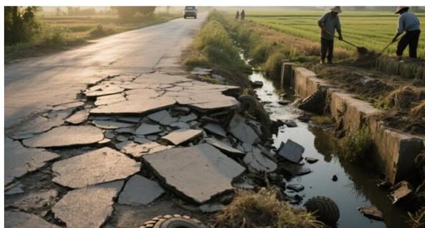
图3 缺乏养护的破损路面
