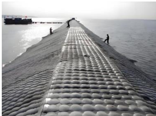
图2 模袋混凝土施工的现场
