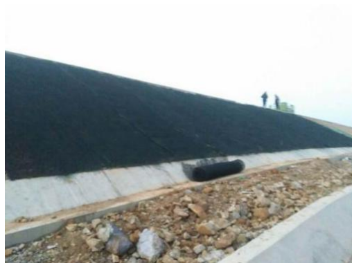
图10 案例三施工中坡面
