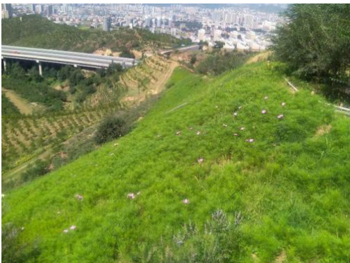
图7 案例二施工后坡面(1)
