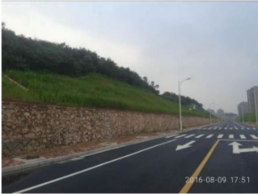
图3 案例一-施工后4个月
