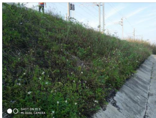
图12 案例三施工后坡面(2)
