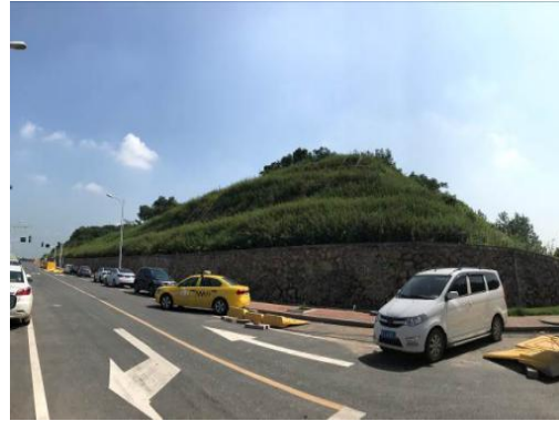
图4 案例一-施工后9个月
