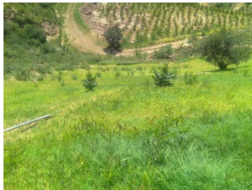
图8 案例二施工后坡面(2)
