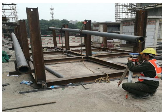
图7 现场钢构件胎架拼装
