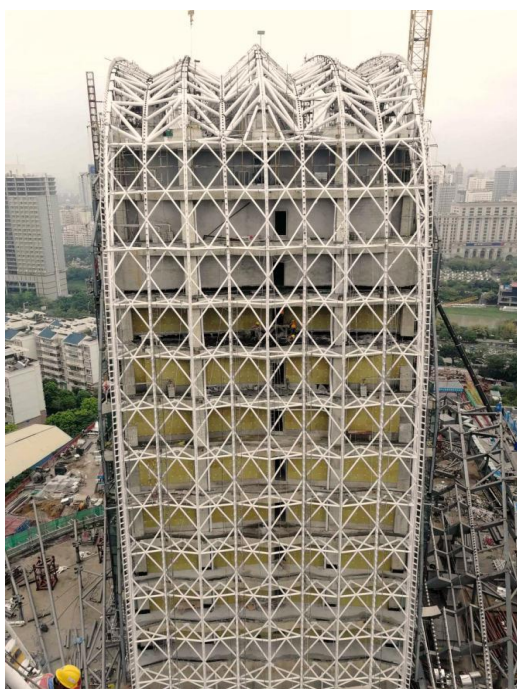
图3 瀑布钢结构安装完成效果
