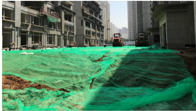
图4 地下室顶板回填土施工
