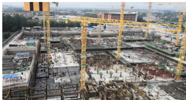
图3 该项目跳仓施工实景图
