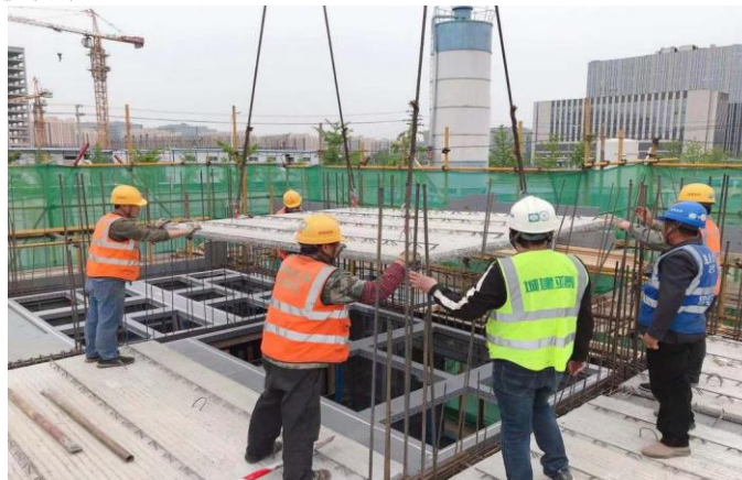
图1 叠合板吊装施工图
