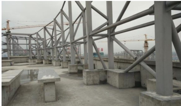
图 6 屋顶钢桁架现场安装
