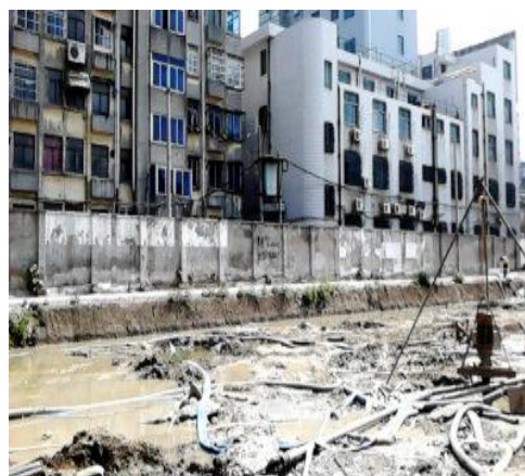
图3 场地南侧靠东住宅小区
