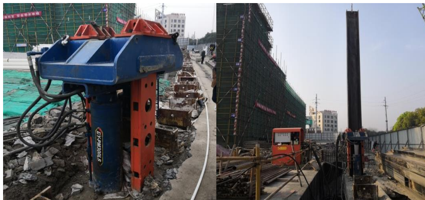
图4 H型钢拔除中
