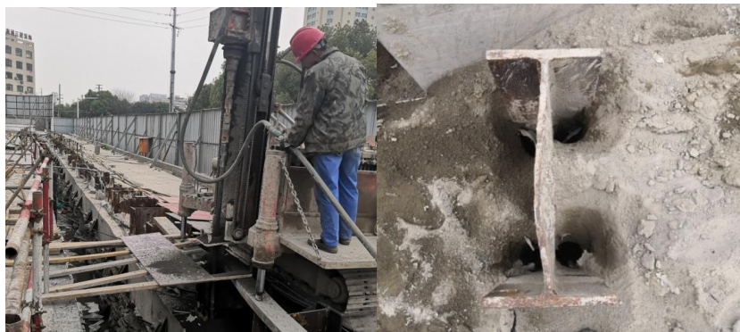
图3 引孔施工
