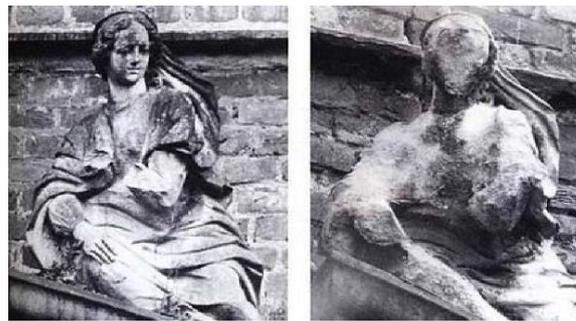
图1 酸雨腐蚀建筑物
