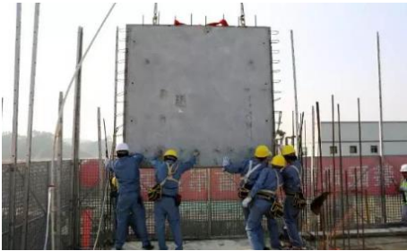
图2 预制件吊装管控是安全管理的重要内容
