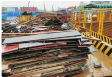
图1 材料违规堆放
