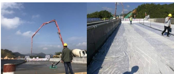
图2 桥面铺装施工
