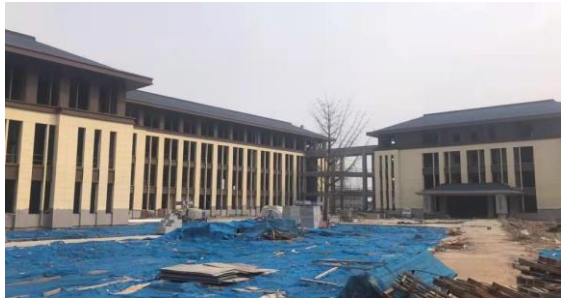
图3 医技楼实景图片
