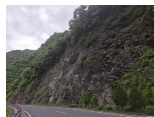
图 10 施工完成后实拍
