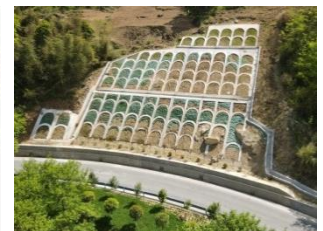
图6 施工完成后实拍
