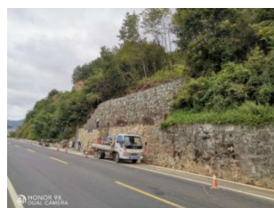
图 8 施工完成后实拍
