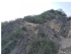
图3 原主动防护网损坏
