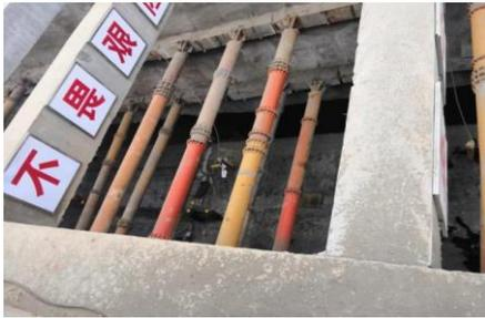
图7 基坑围护结构示意图
