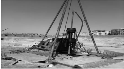
图 2 钻心法现场检测
