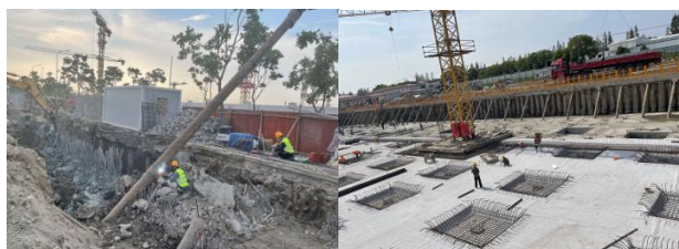
(c) 前撑式注浆钢管焊接 (d) 前撑式注浆钢管开挖照片
