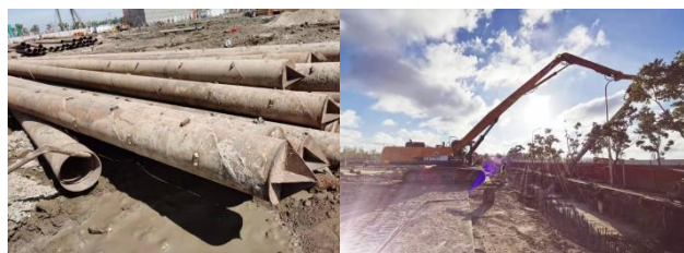
(a) 加工完成的前撑式注浆钢管 (b) 前撑式注浆钢管沉桩
