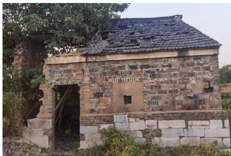
图2 典型空斗墙砌筑方式
