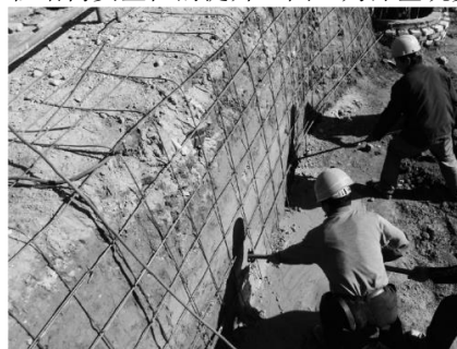
图 1 深基坑支护现场示意图
