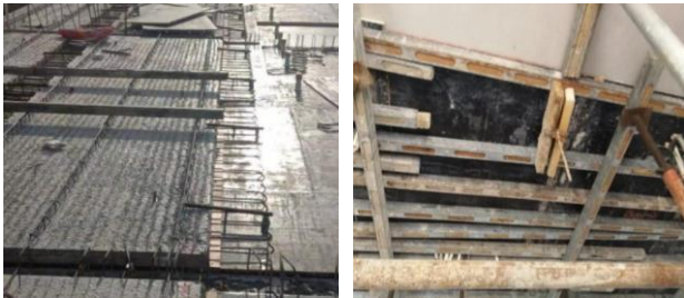
图 5 现场加固照片
