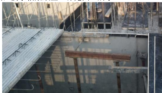
图4 模板支设完粘贴海绵条
