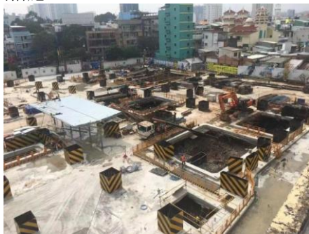
图2 逆作法施工首层布置图
