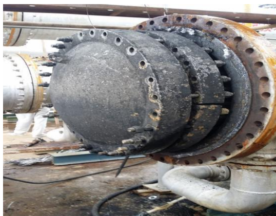
E-122/B 冷却器内浮头照片
