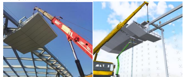
图11 檐口模块整体吊装示意图
