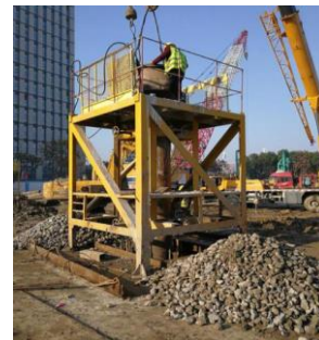
图2 混凝土浇筑作业准备
