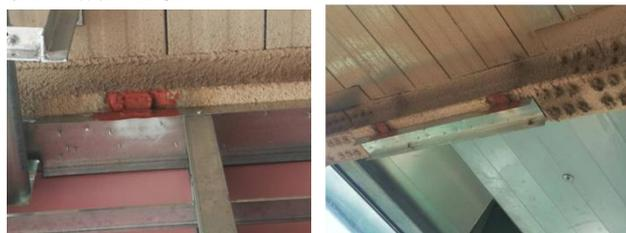
图5 角码与钢结构连接
