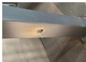
图 15 轻钢龙骨通过螺柱与钢结构连接
