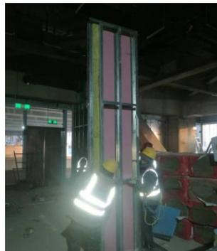
图 16 轻钢龙骨隔墙预拼装
