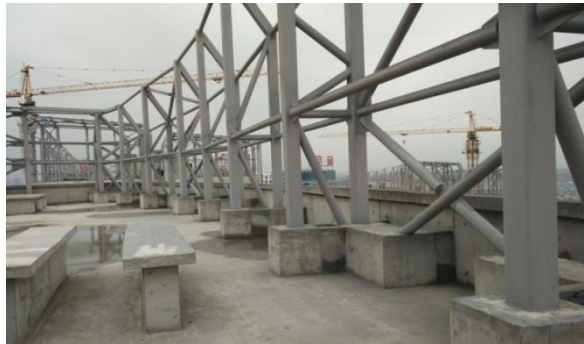
图 6 屋顶钢桁架现场安装
