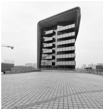
图 5 楼间连廊平台
