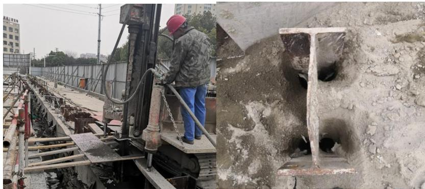
图3 引孔施工
